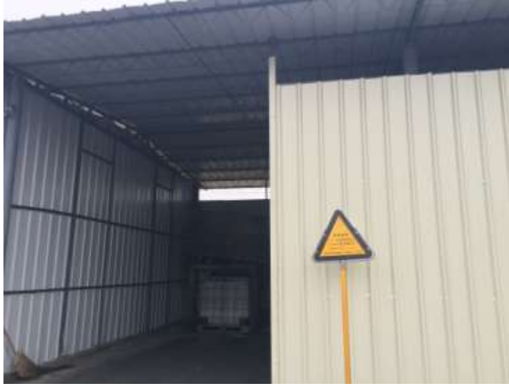
危险废物暂存间标识
